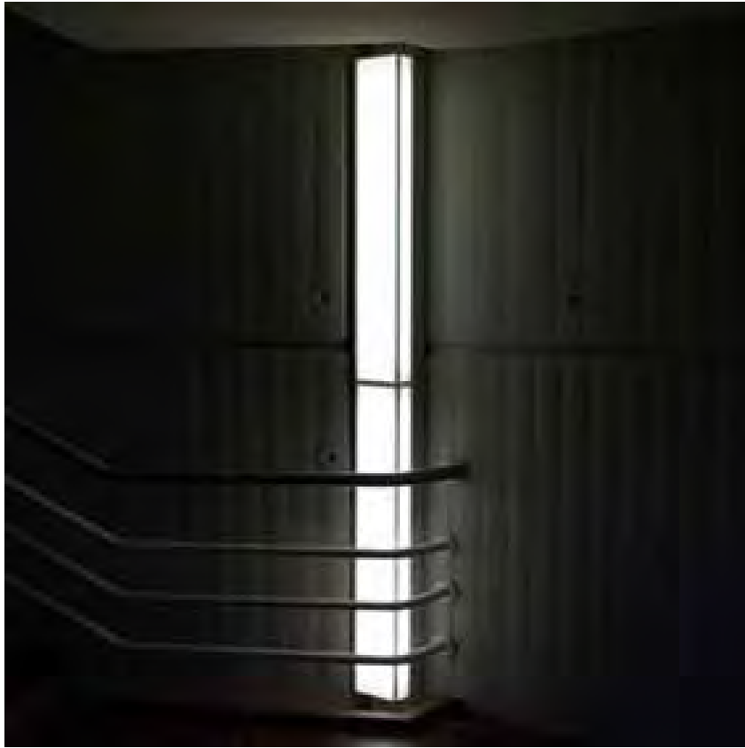
Vertikale Lichtbandleuchte für Treppenhäuser der Siemens Financial Services München
